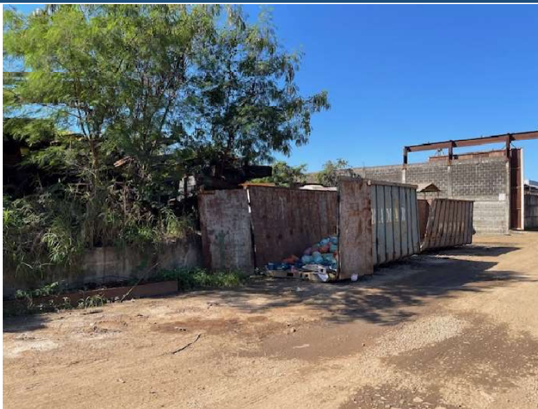
Figura 18 - Caçambas para a coleta de material
