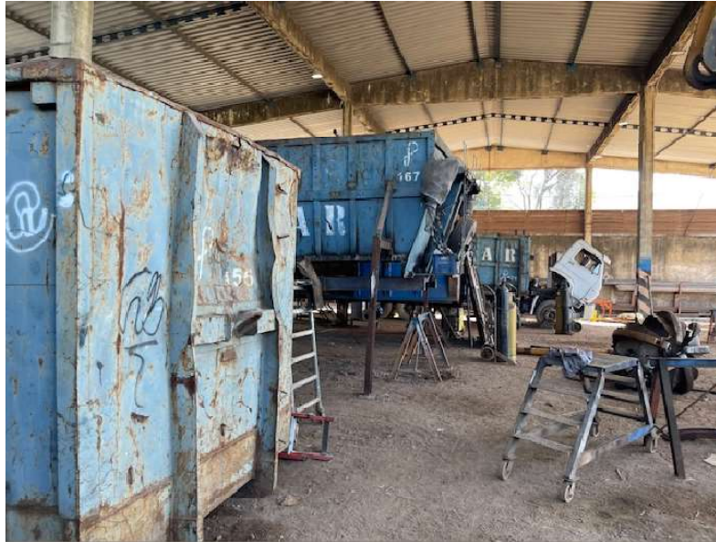
Figura 20 - Oficina para reparo das caçambas
