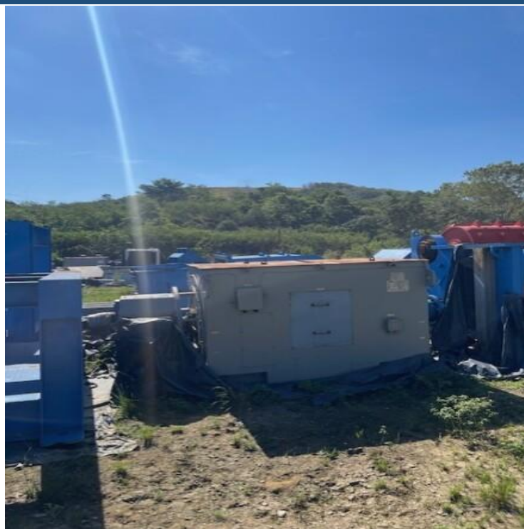
Figura 13 - Motor elétrico do moinho
