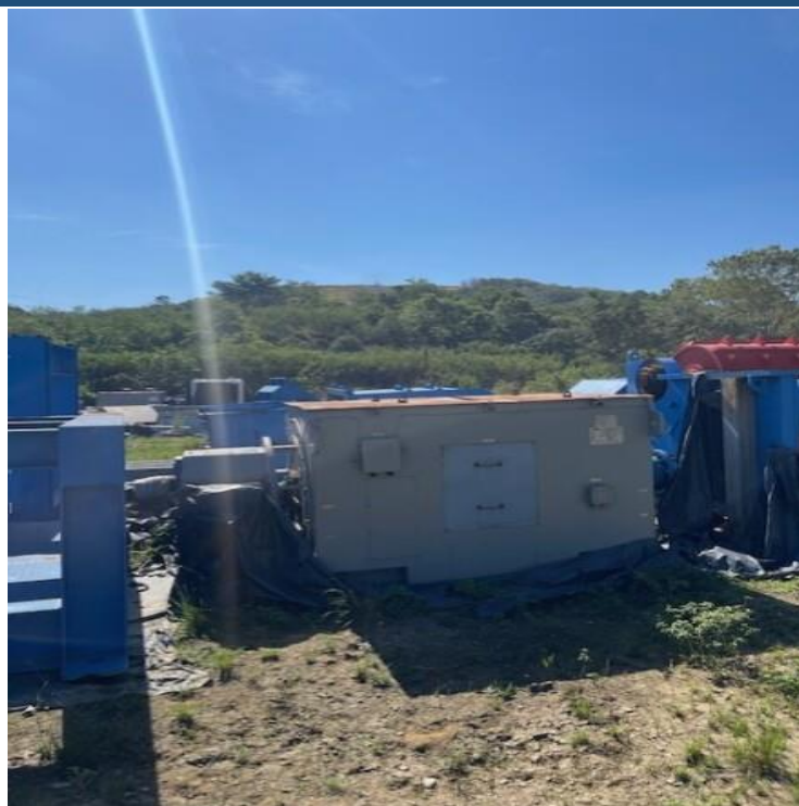
Figura 13 - Motor elétrico do moinho
