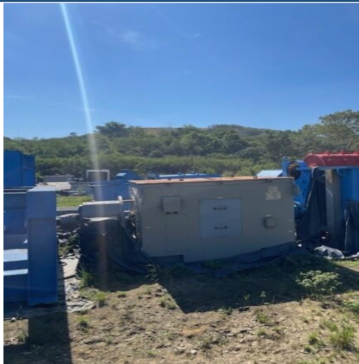
Figura 7 - Motor elétrico do moinho
